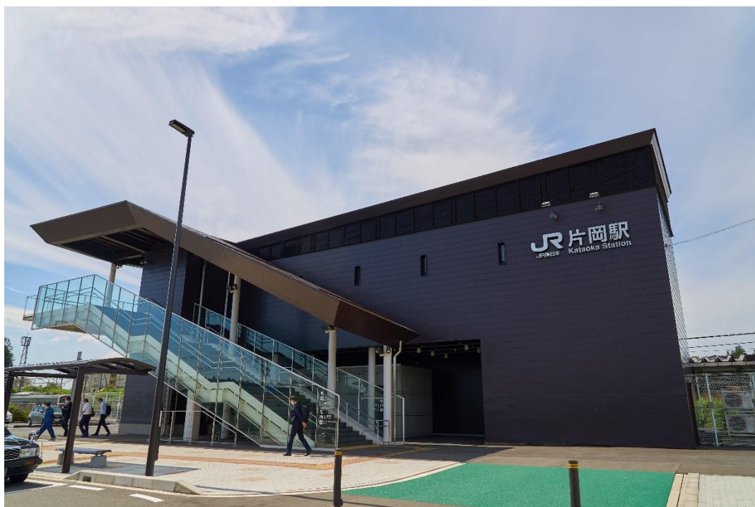
耐久性に優れた材料を用いた建築物 (JR 片岡駅)
