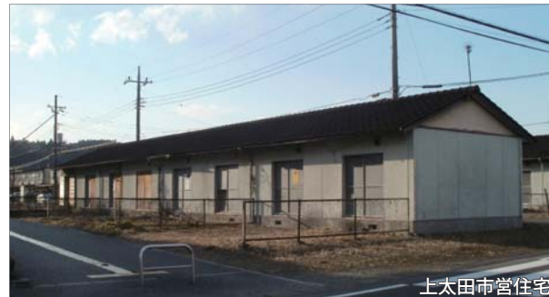
上太田市営住宅
