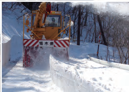
維持工事（除雪）
