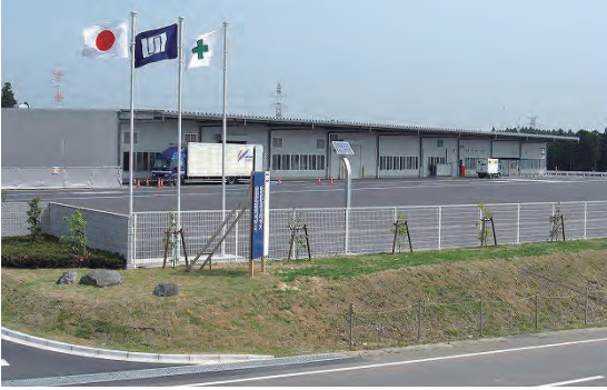
矢板工場全景
