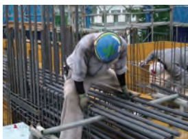
現場取付風景
