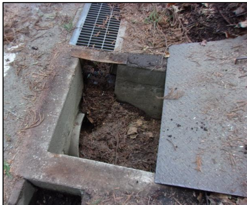
図3:側溝清掃前②
