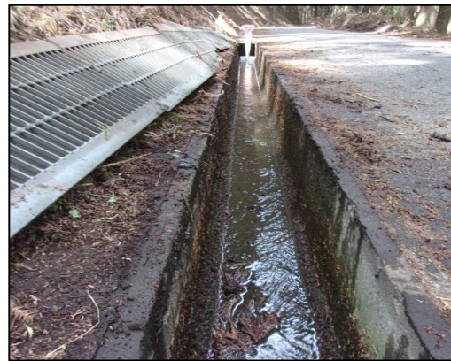
図2:側溝清掃後①
