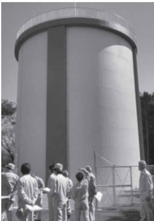
中央配水池現地調査
