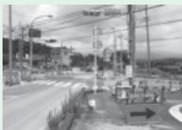
改修の進む幸岡交差点
