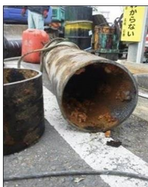
老朽化した水道管
