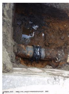
水道管の漏水工事
