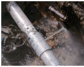
水道管の漏水工事
