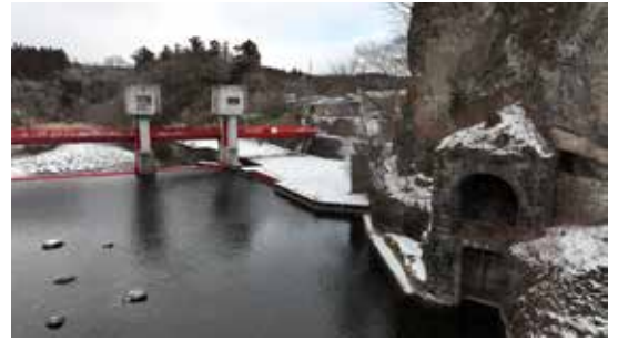
▲那珂川の水を取り入れる那須疏水の取入口。むかつて右のがけにあるのが旧取入口、現在使われている左の施設は1976年（昭和51年）に完成した。
