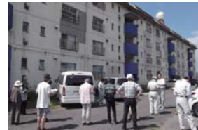
▲現地調査の様子(中市営住宅)
