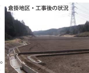
倉掛地区・工事後の状況
