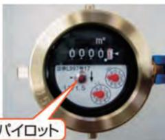
まだパイロットが回っていたら、敷地内給水管のどこかで漏水しています。
