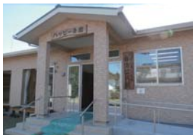
▲建設された自治公民館
