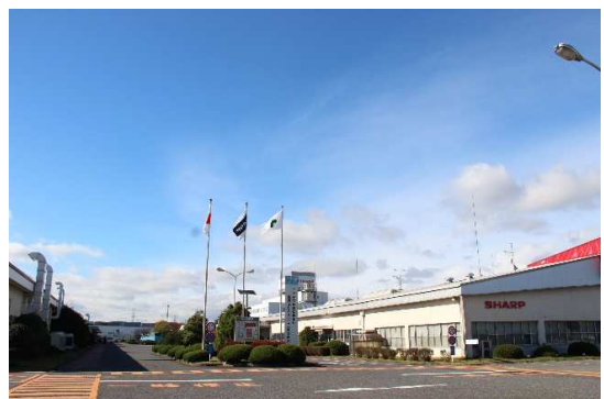
矢板工業団地
