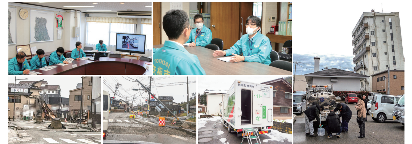
▲突き出てしまったマンホール ▲傾いたまま使用される信号機 ▲トイレカー。全国から支援の力が ▲給水ポイントの奥には傾いたビルも
