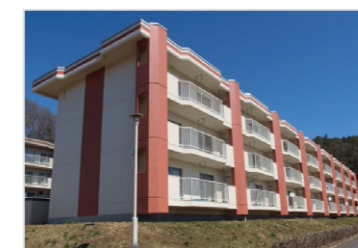
平成27年3月に 屋上・外壁改修を行った 高倉市営住宅1号棟
