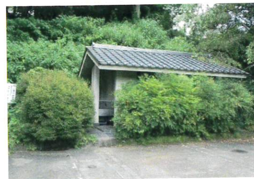
(西側駐車場にあるトイレ)
