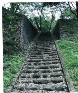
○本丸へのスロープ設置
