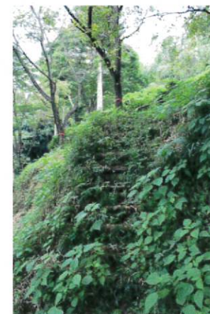
○壊れた園路の整備
