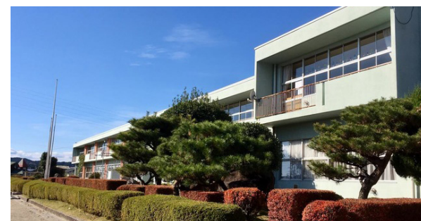
東小学校の大規模な施設整備
