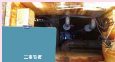
(工事後)新設機器設置状況
