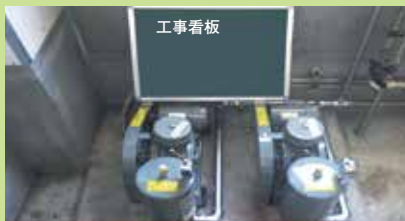
(工事後)新設機器設置状況
