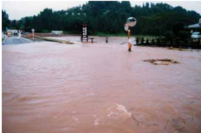
平成10年 那須災害(川崎反町地内)
