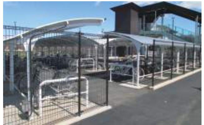
片岡駅西自転車駐車場
