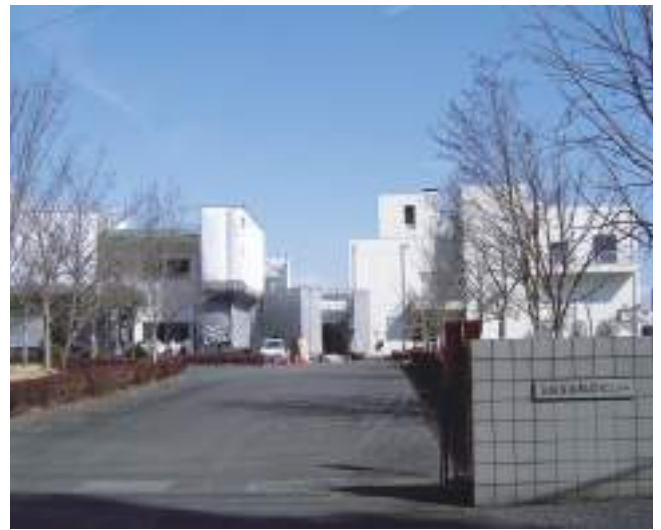
水処理センター
