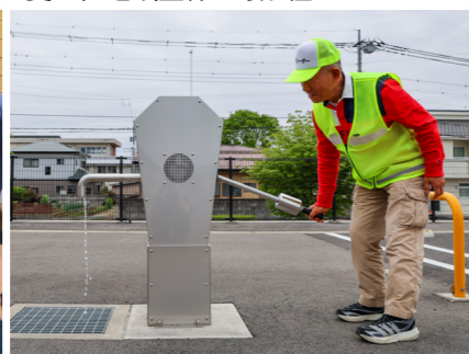
▲文化スポーツ複合施設敷地内にある防災井戸。市では断水時に生活用水を提供いただく「災害時協力井戸」への登録も呼びかけています。
