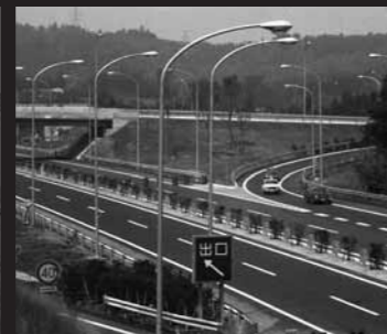
矢板インターチェンジ開通
