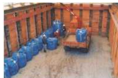
廃棄物定置作業
