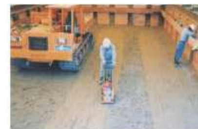
覆土施工状況
