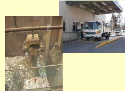
裁断した牧草を焼却施設へ運搬。ゴミピットに投入し焼却
