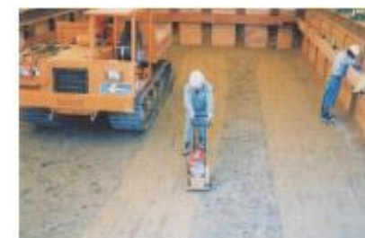
覆土施工状況
