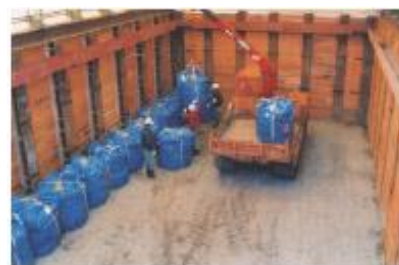
廃棄物定置作業
