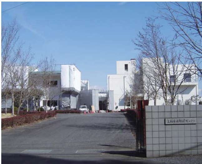
水処理センター
