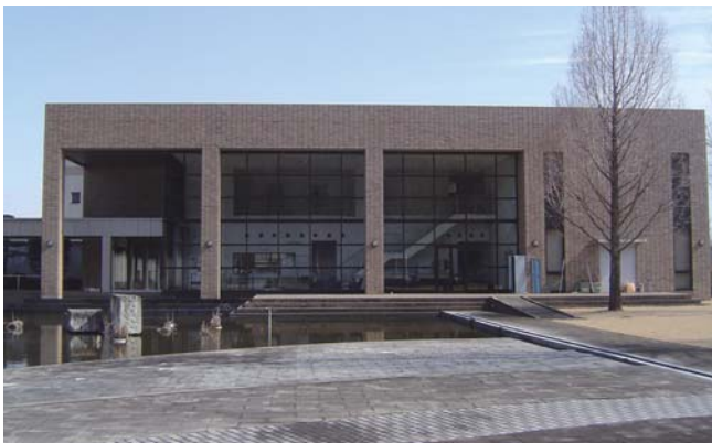
塩谷広域行政組合し尿処理施設(クリーンセンター)管理棟
