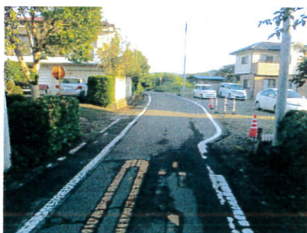
荒井地内の待避所設置工事
