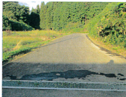
境林地内の舗裝修繕工事(延長210m)
