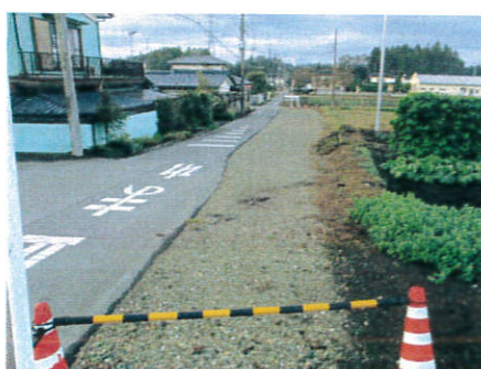
中地内の認定外道路の暫定拡幅
