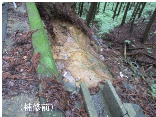
(林道施設(側溝)の破損)
