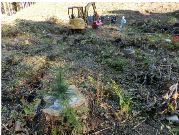
作業後の刈払状況
