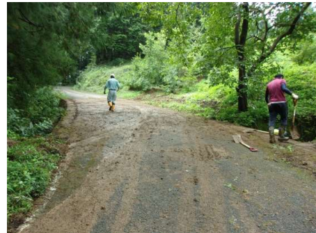
図4: 土砂を除去した
