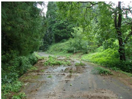
図3: 林道に流出した土砂
