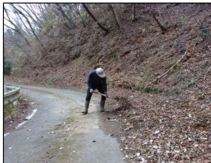
図5: 土砂清掃作業①
