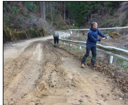
図6: 土砂清掃作業②
