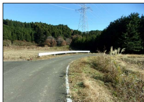
図6: 草刈り作業 作業後
