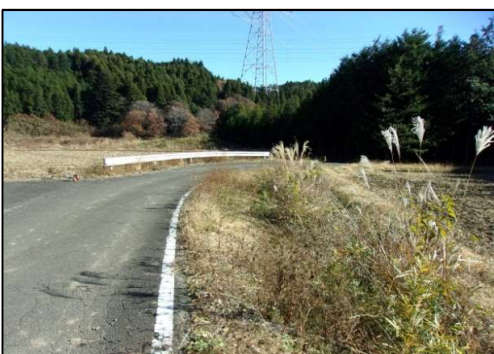
図5: 草刈り作業 作業前
