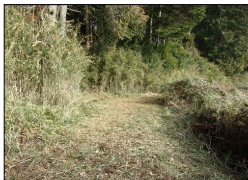
図6: 倒木処理 作業後
