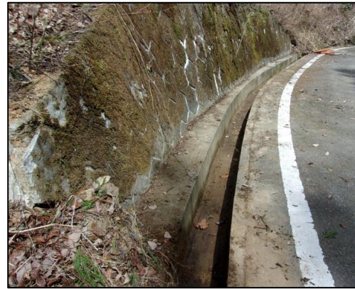
図2:側溝清掃後①
