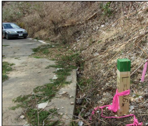
図3:側溝清掃前②
