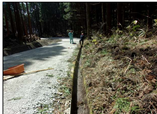
図2:側溝掃除後①
