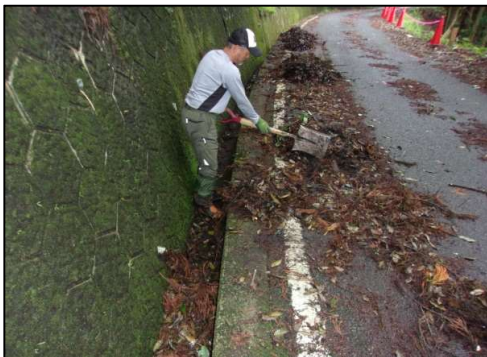
図5:掻き出し作業①
