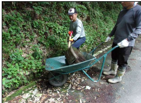
図6:掻き出し作業②
