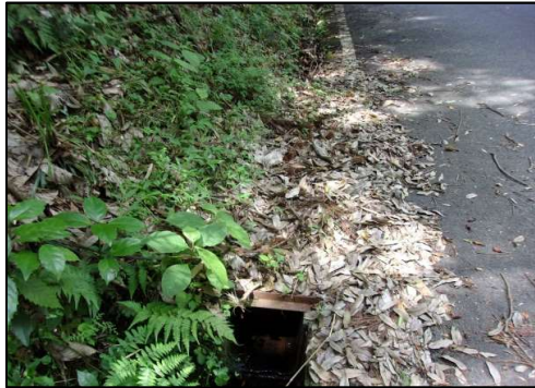
図1:側溝清掃前①
