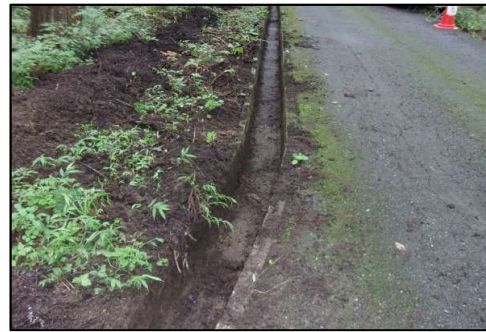
図2: 側溝清掃後①
