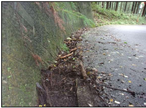
図3: 側溝清掃前②
