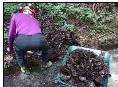
図6: 作業中の様子②
