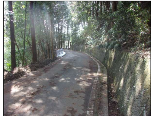
図2: 走行路清掃作業後①
