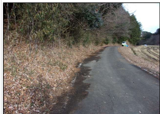
図2: 走行路清掃作業後①
