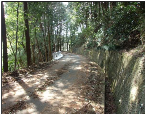
図1: 走行路清掃作業前①
