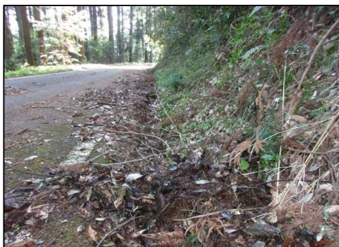
図3: 側溝清掃作業前①
