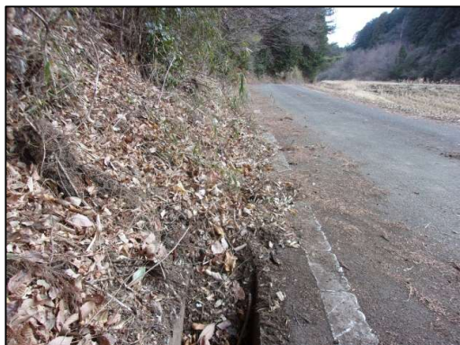
図3: 側溝清掃作業前①
