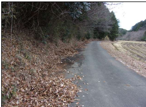
図1: 走行路清掃作業前①
