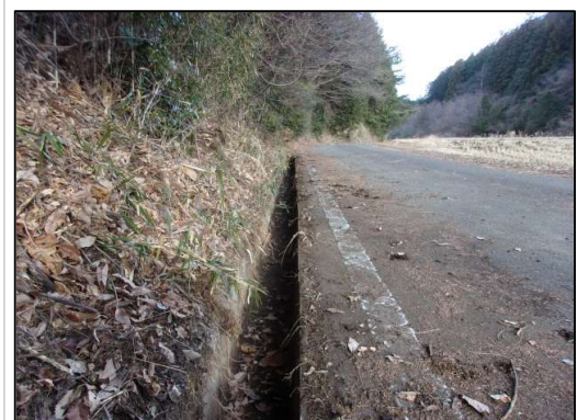
図4: 側溝清掃作業後①
