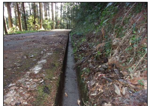
図4: 側溝清掃作業後①
