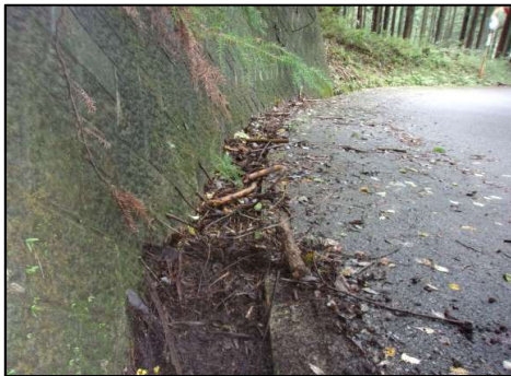
図3:側溝清掃前②
