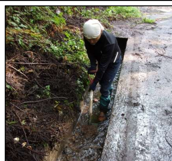
図5: 作業中の様子
