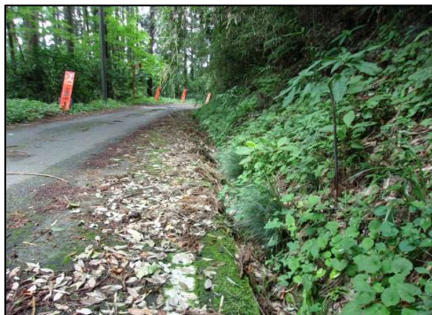
図3: 側溝清掃前②
