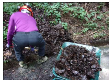
図6:作業中の様子②
