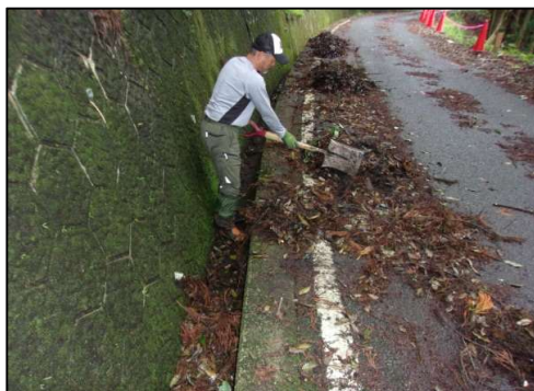
図5: 掻き出し作業①
