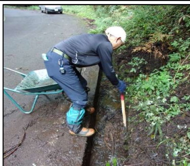
図4: 作業中の様子
