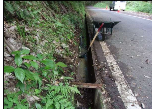
図2: 側溝清掃後②
