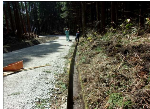
図2:側溝掃除後①
