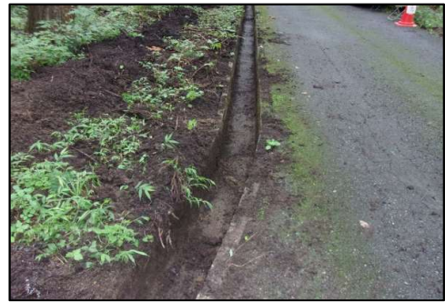
図2:側溝清掃後①
