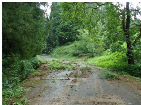
図3: 林道に流出した土砂
