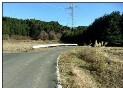
図6:草刈り作業 作業後
