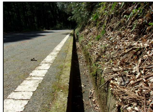
図4: 側溝清掃後の様子②
