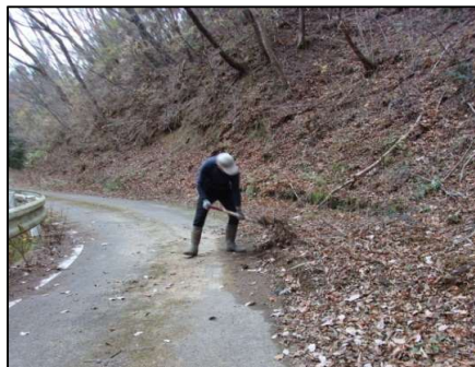
図5: 土砂清掃作業①
