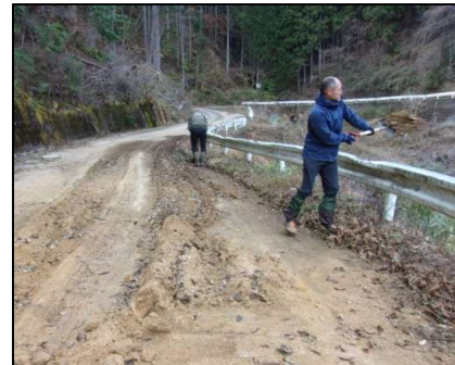
図6: 土砂清掃作業②
