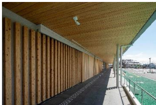
(外壁木ルーバー、軒裏羽目板)
