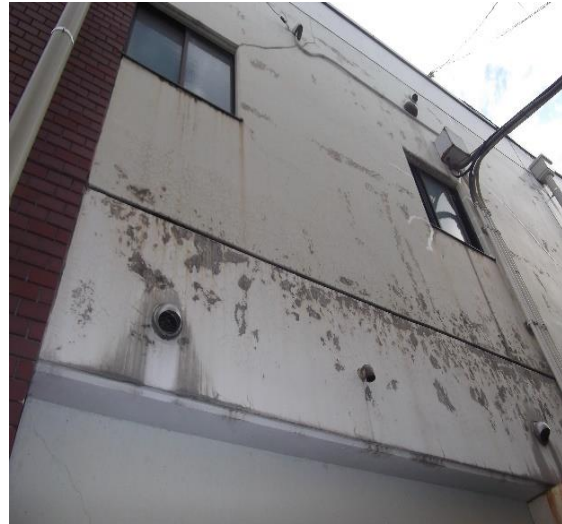
12 場所：福祉会館 北側外壁 状況：外壁剥離、ひびわれ
