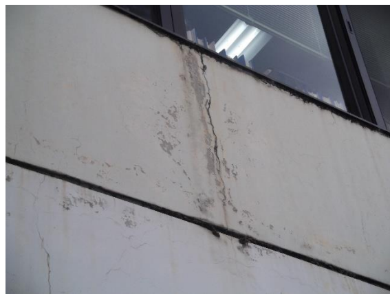
12 場所：福祉会館 北側外壁 状況：外壁剥離、ひびわれ
