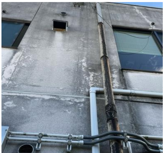
11 場所：保健センター 北側外壁 状況：外壁剥離、ひびわれ、腐食
