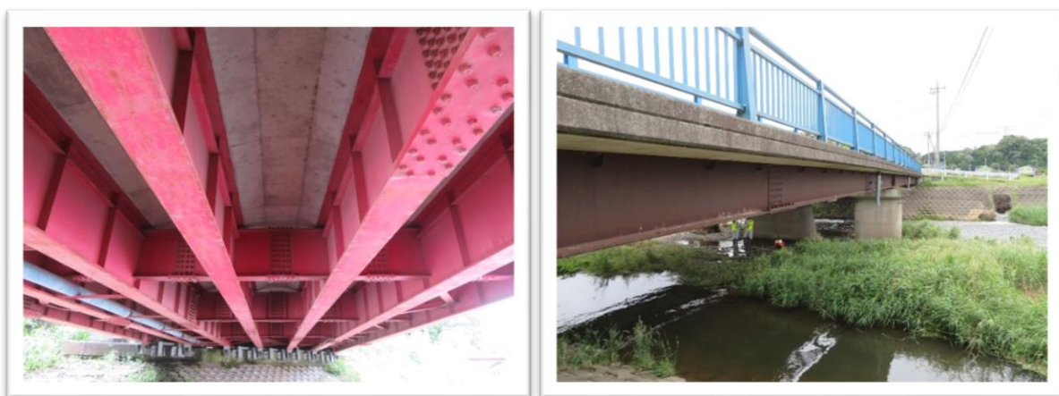
対象施設の一例（左：内川橋/右：田中橋）
