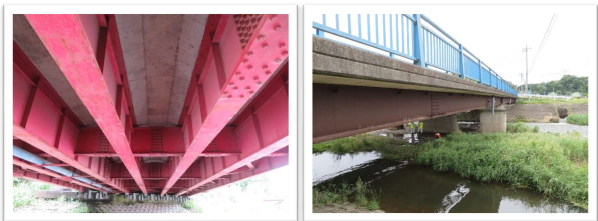
対象施設の一例（左：内川橋/右：田中橋）
